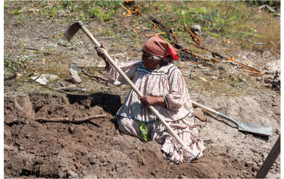
En la faena para la construcción de la represa de Hierbanís.
