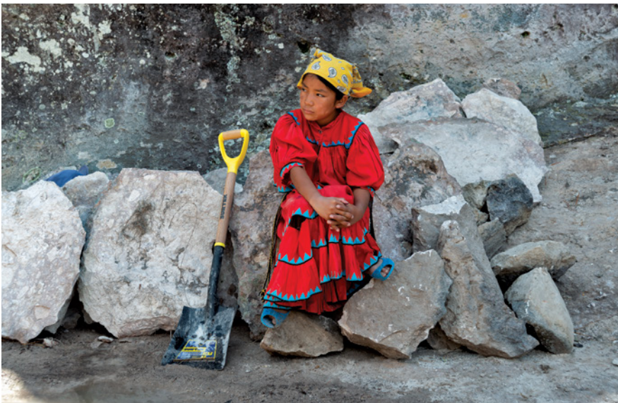
En las labores de construcción de la represa de Mawarichi.
